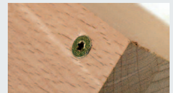
Sauberes Verschrauben ohne Vorbohren und Vorsenken
