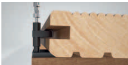
Dabei die Schraube nicht sofort vollständig eindrehen. Dadurch lässt der Kunststoffgleiter genügend Spiel für das Ansetzen der Terrassendiele
