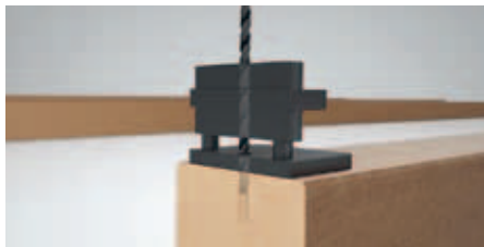
Terrassengleiter aufsetzen und Unterkonstruktion ggf. vorbohren
