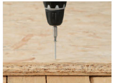
Beziehen und Fixieren des Belages mit nur einer Schraube
