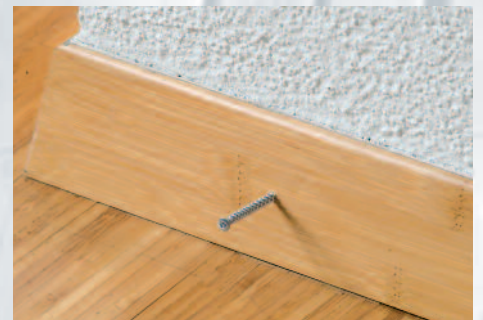
Befestigung von Sockelleisten
