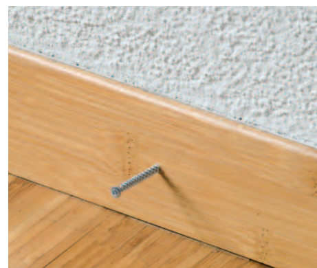
Befestigung von Sockelleisten
