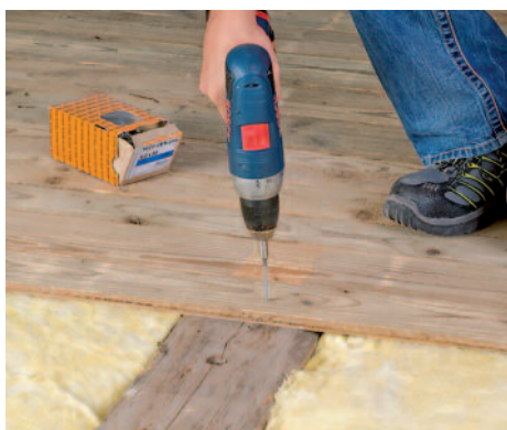
Bodenbretter-Befestigung
