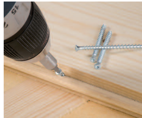
Dielenboden-Verschraubung
