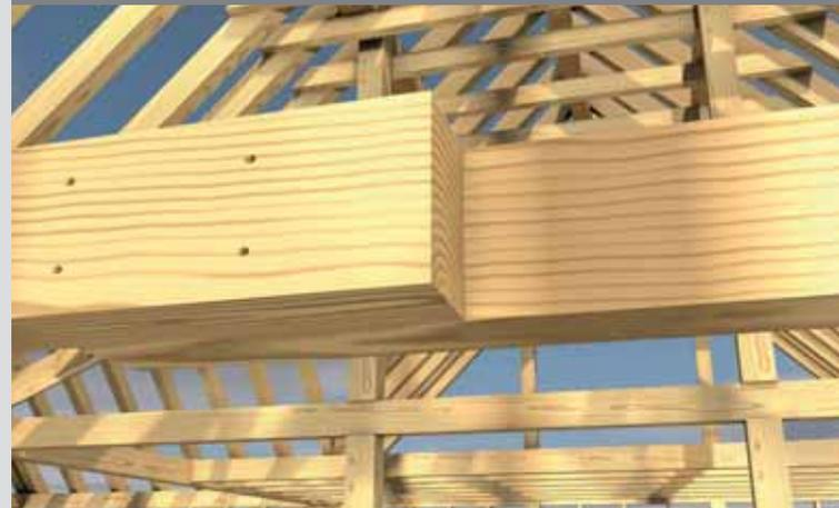
Alternativ können Vollgewindeschrauben auch bei Zugscherverbindungen eingesetzt werden. Durch das Eindrehen unter einem Winkel werden die Schrauben auf Zug beansprucht und können somit sehr hohe Lasten übertragen.
