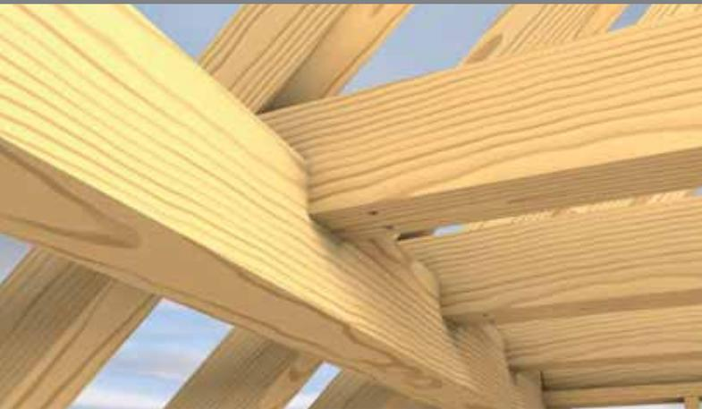
Trägerausklinkung am Auflagerbereich zur Verringerung der Bauteilhöhe (z.B. bei der Altbausanierung). Mittels Vollgewindeschrauben kann die Querkrafttragfähigkeit erhöht werden.
