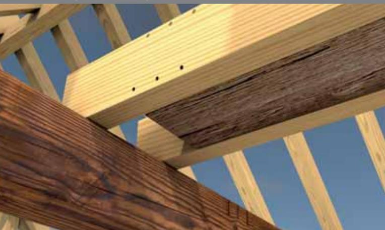
An alten Holzbalkendecken treten häufig Holzschäden, zumeist am Auflagerbereich, auf. Mittels seitlich aufgeschraubten Holzlaschen, kann die Tragfähigkeit wieder hergestellt werden.
