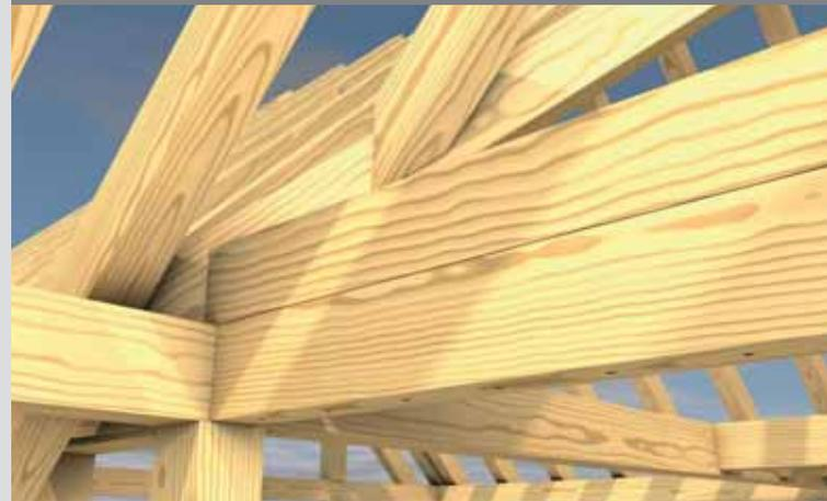
Durch zusätzliche Aufbringung von Lasten, reichen ursprünglich geplante Balkenquerschnitte statisch oftmals nicht mehr aus. Die Lösung ist eine sogenannte Aufdopplung in Verbindung mit geneigt eingedrehten Vollgewindeschrauben, welche den Schub in der Fuge übertragen.
