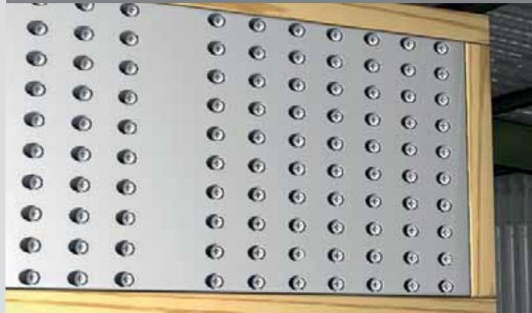
Speziell im Holzbau werden des öfteren eigens angefertigte Sonderstahlteile hergestellt. Da an solchen Knotenpunkten enorme Lasten abgeleitet werden müssen, sind Spanplattenschrauben mit Senkköpfen unumgänglich.
