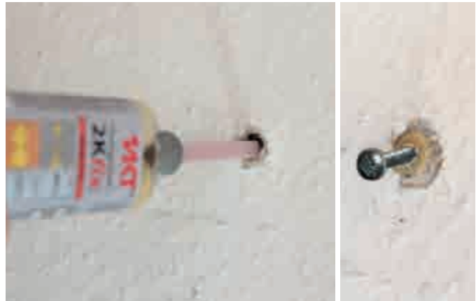
Flüssigdübel 2Kfix Statikmischer Mischverlängerung Siebhülse
