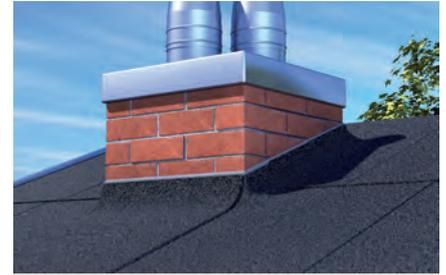
Abdichtungen an Dächern mit Bitumenbahnen
