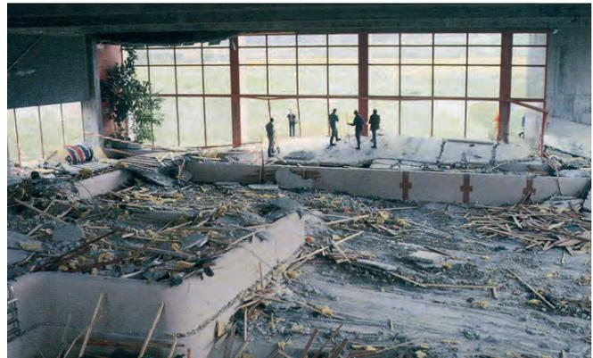
1985 versagte die abgehängte Betondecke eines Hallenbades im schweizerischen Uster. Die Aufhängungen der Decke aus nichtrostendem Stahl A2 zeigten rein äußerlich keinerlei Mängel, waren jedoch innerlich teilweise vollkommen durch Spannungsrisskorrosion zerstört.
