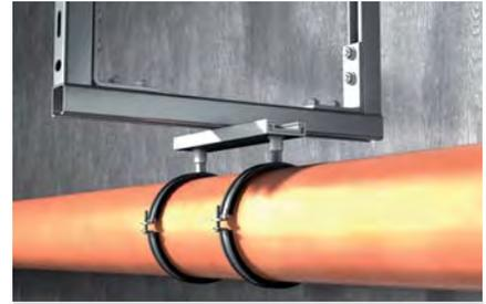
Längenausdehnung mit Gleitelement und hängendem Rohr
