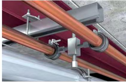
Mehrfachbefestigung mit Montagewürfel
