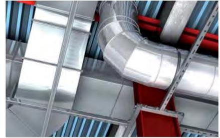
Tragekonstruktion für Lüftungsanlagen
