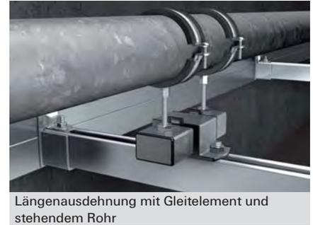
Längenausdehnung mit Gleitelement und stehendem Rohr
