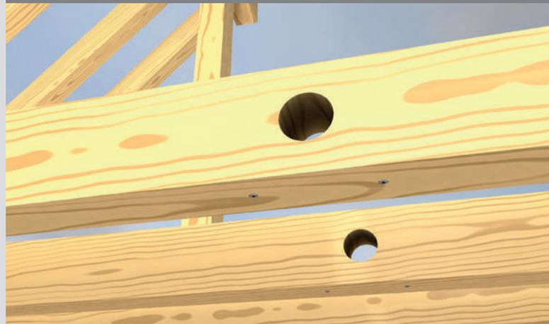
Trägerdurchbrüche dienen zu Rohrleitungsführungen sowie Installationsleitungen aller Art. Die Trägerschwächung kann mittels Vollgewindeschrauben kompensiert werden.
