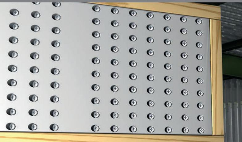
Speziell im Ingenieur-Holzbau werden des öfteren eigens angefertigte Sonderstahlteile hergestellt. Da an solchen Knotenpunkten enorme Lasten abgeleitet werden müssen, sind Vollgewindeschrauben mit Senkköpfen unumgänglich.
