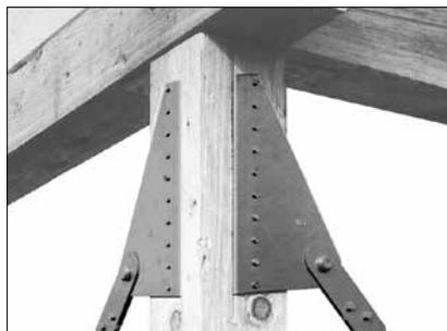
Detail an Eckstütze: Bandanschluss BNF25 mit Kopplungsverbinder BNKK25. Der gekantete Abschnitt des BNF25 ist in einem 70 mm von der Stützenkante entfernten, 16 mm tiefen Schlitz eingelassen.
