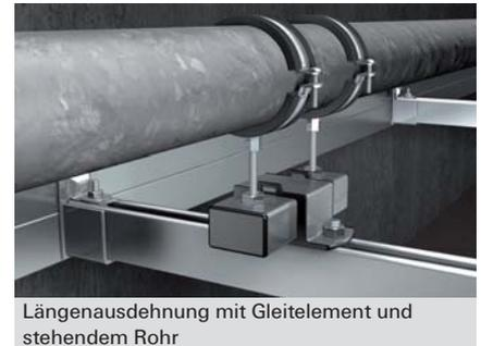
Längenausdehnung mit Gleitelement und stehendem Rohr
