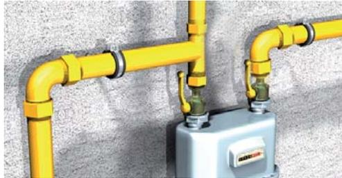
**Auf Basis der DVGW-TRGI Neufassung im Jahr 2008 hat sich für die Befestigung von Rohrleitungen eine Konkretisierung für die einsetzbaren Dübel ergeben. Geregelt wird dies in der TRGI 2008 im Kapitel II unter Punkt 5.3 "Erstellung von Leitungsanlagen". In der TRGI aus dem Jahr 2008 sind nun unter bestimmten Bedingungen Kunststoffdübel ausdrücklich erlaubt.**
