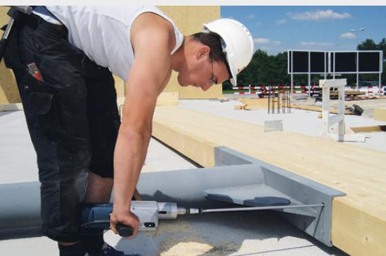
**Ausführung:** HECO-WR Spezial-Vollgewindeschraube, Senkkopf
