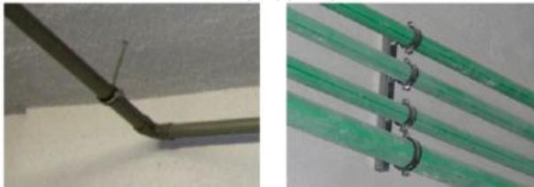
Gelenkrohrschelle mit Schallschutzeinlage M8 und Schnellverschluss
