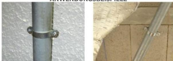
Massivrohrschelle mit Schallschutzeinlage M8 seitlich
