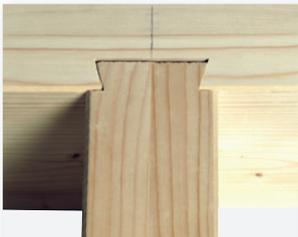
Für Schwalbenschwanz-Verbindungen an Tragbalken oder Sparren.
