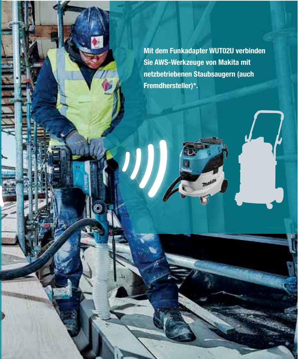
Mit dem Funkadapter WUT02U verbinden Sie AWS-Werkzeuge von Makita mit netzbetriebenen Staubsaugern (auch Fremdhersteller)\*.
