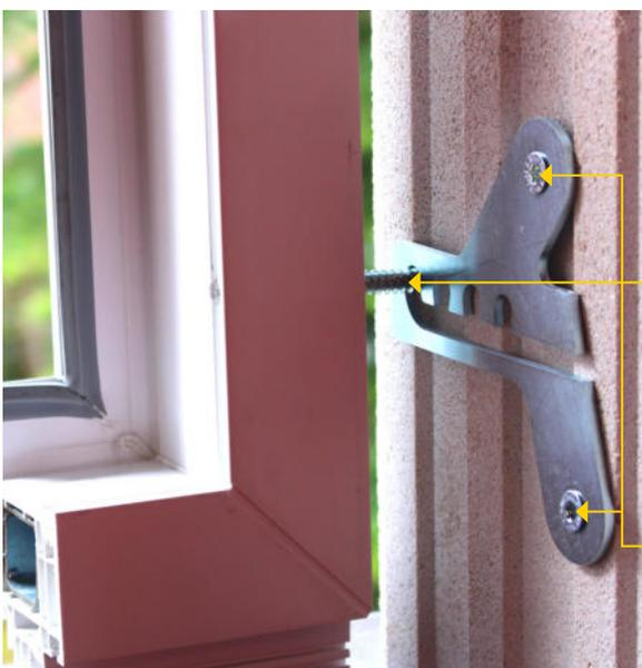
Fensterbauschraube FBS-Z 7,5-152 oder Fensterbauschraube FBS-Z 7,5-212
